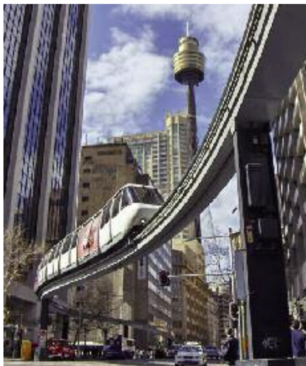
Monorriel sobre viga (Sydney - Australia)
