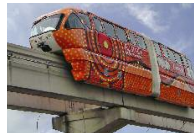
Monorriel sobre viga en Kuala Lumpur
